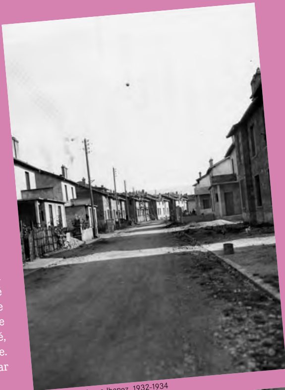
Cottages, rue Blasco-Ibanez, 1932-1934
