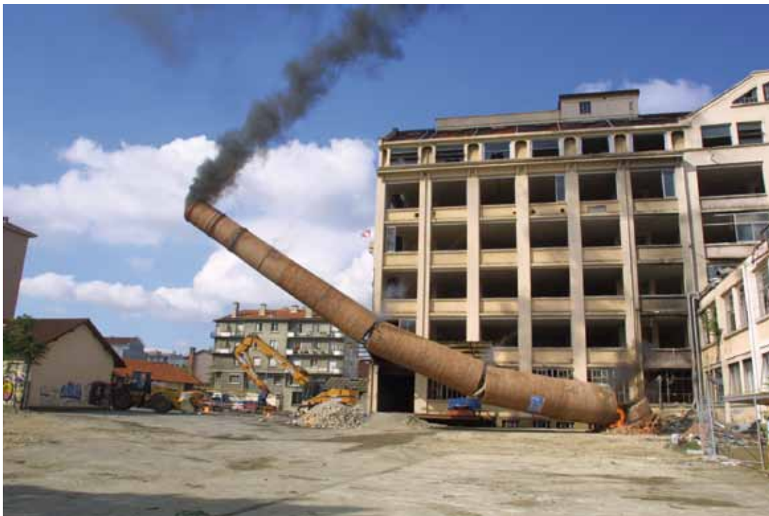
Démolition de la cheminée de l'entreprise Bally, 2002, photographie © Gilles Michallet - Ville de Villeurbanne
