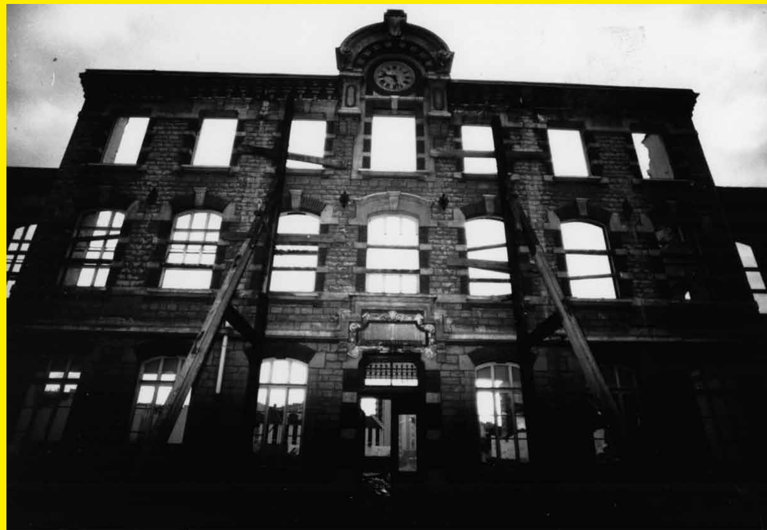
Façade de l'imprimerie Arnaud avant démolition, 1992, photographie © Collection particulière
