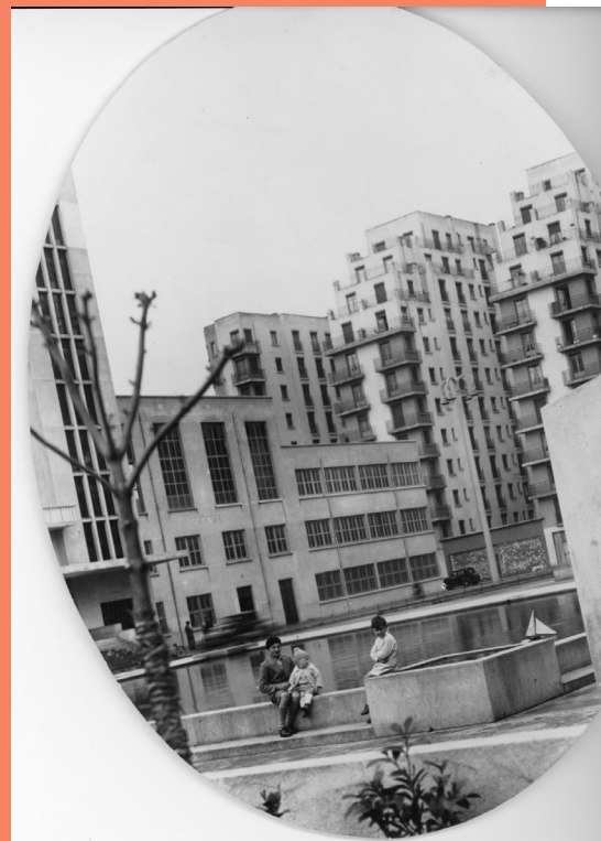
Vue_sur_un_bassin_de_la_place_Lazare_Goujon _avec_trois_personnes.Villeurbanne,1931-1934. Photographie_4fi298@Jules_Sylvestre.Coll.AMV
